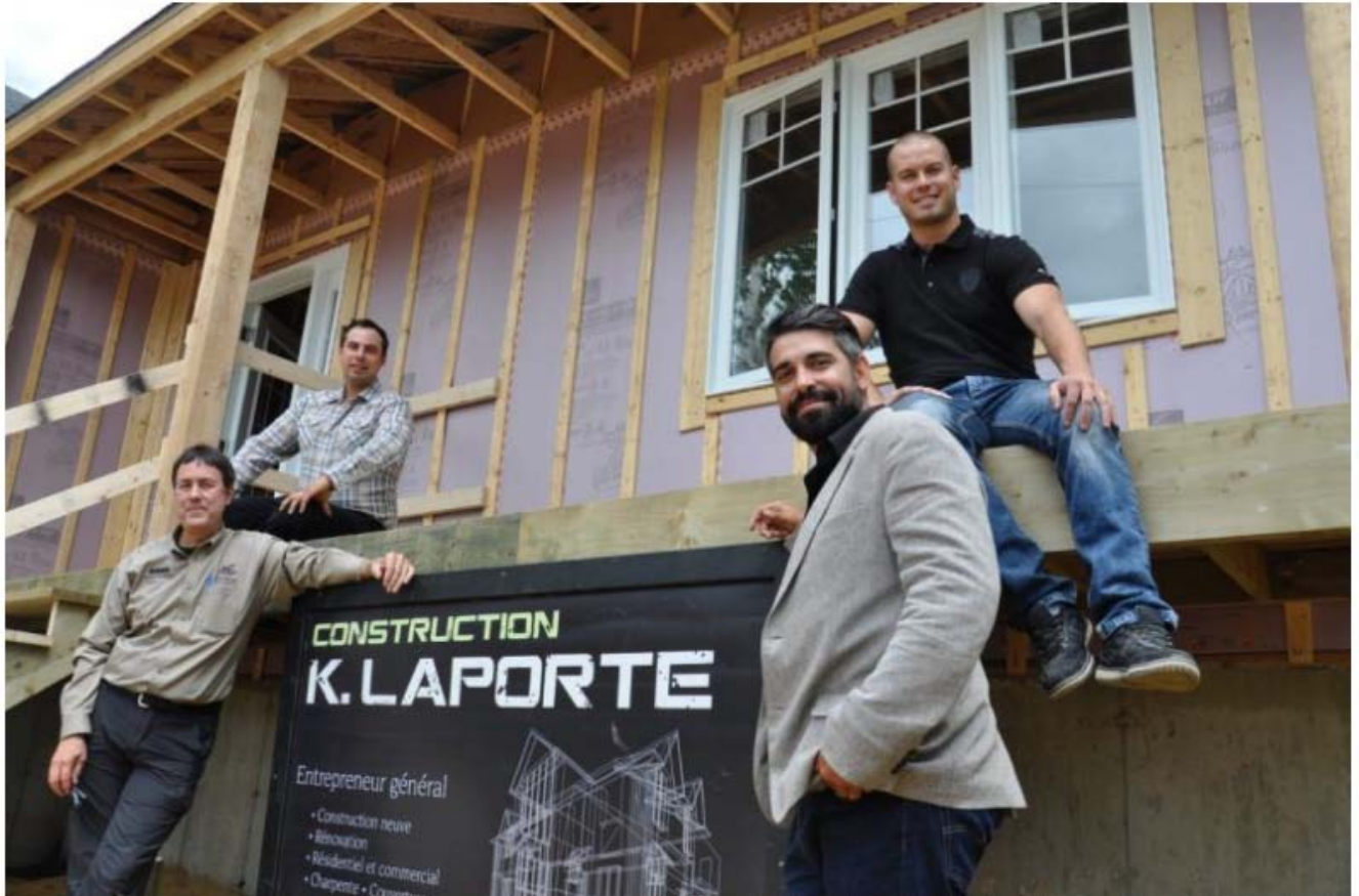
Des acteurs de la construction de la maison écoénergétique de la rue Piché à Mont-Tremblant: de gauche à droite, Guillaume Charette (Construction K. Laporte), Yvon Gignac (BMR Groupe Yves Gagnon de Mont-Tremblant), Keven Laporte (président de Construction K. Laporte) et George Mantzoros (Owens Corning). ©Photo TC Media - Yves Rouleau
